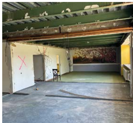
Wanddurchbruch alter Büroräume in der Verwaltung und Intendanz
