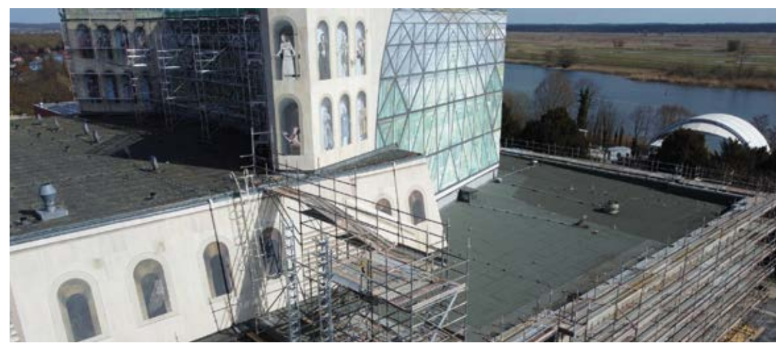
Einrüstung der kompletten Fassade des Großen Hauses
