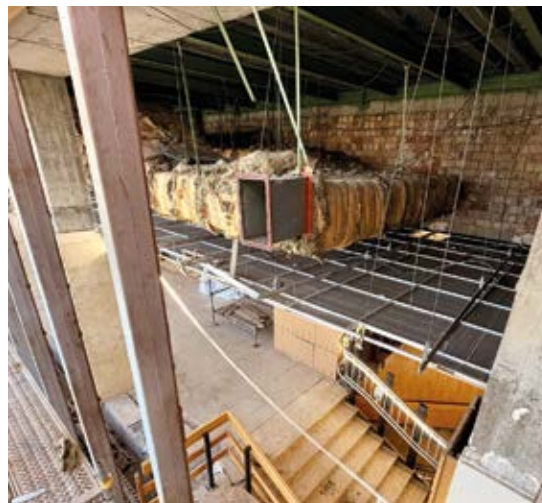
Freilegung Fensterfront und Lüftung Foyer Großes Haus
